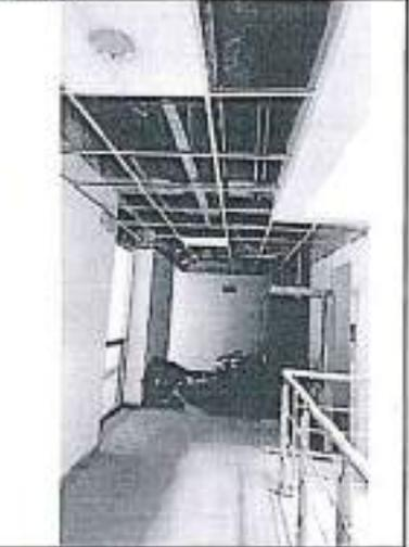
En los SS. HH. que no cuentan con ventilación natural, se ha implementado la ventilación mecánica a través de rejillas conectadas a extractores, los mismos que se conectan al sistema de ventilación general, conforme se advierte de la imagen.
